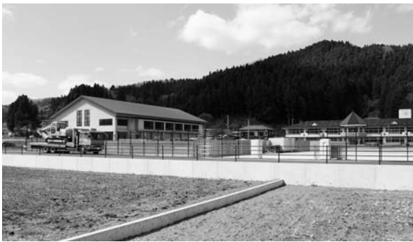
進む統合小学校増築工事
