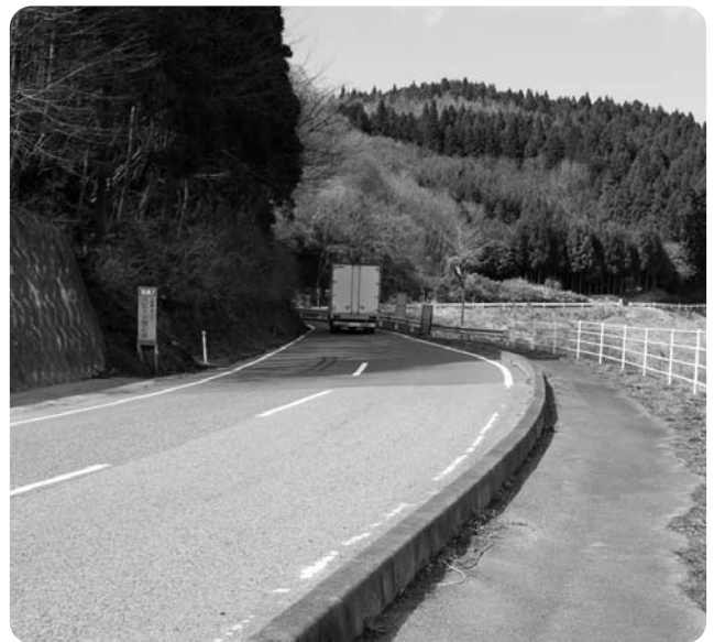
重要な道路整備（山上字土鍋地内）
