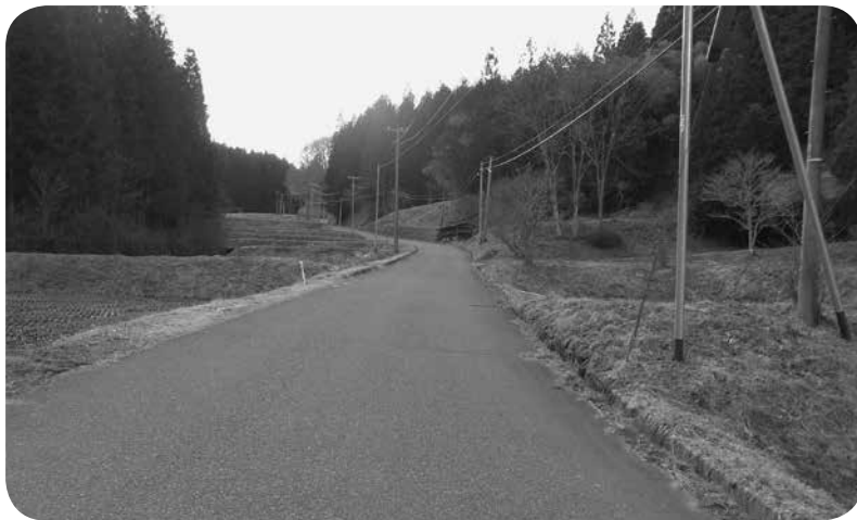
町道 才竜内石神線 大久田字西作地内
