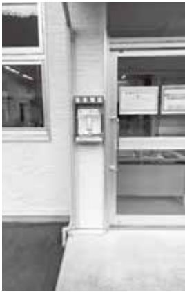
▲古殿分署の設置状況
