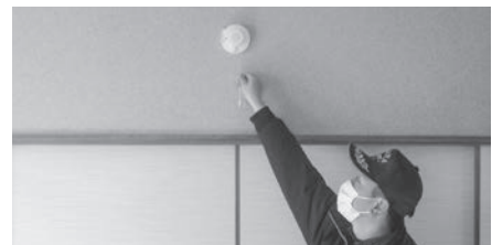
▲ 住宅用火災警報器の設置状況を確認
