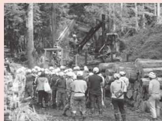
作業現場にて
