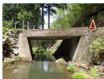
側面全景（右側：越代熊倉線）
