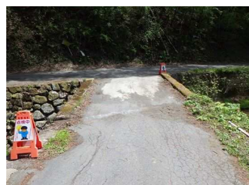
正面全景（奥側：越代熊倉線）
