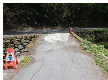
正面全景（奥側：越代熊倉線）
