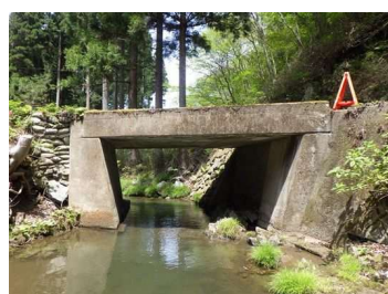
側面全景（右側：越代熊倉線）
