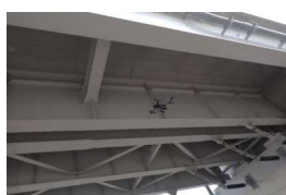
ドローンによる桁下の点検
