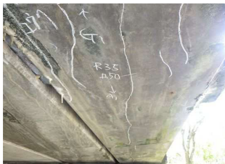
002. 亀久保：プレテン中空床版橋 (橋長：14.56m、1984年竣工) プレテン桁下面・側面のひびわれ ※雨水の浸入により、ASRの損傷は進行する可能性がある。(迂回路有り)
