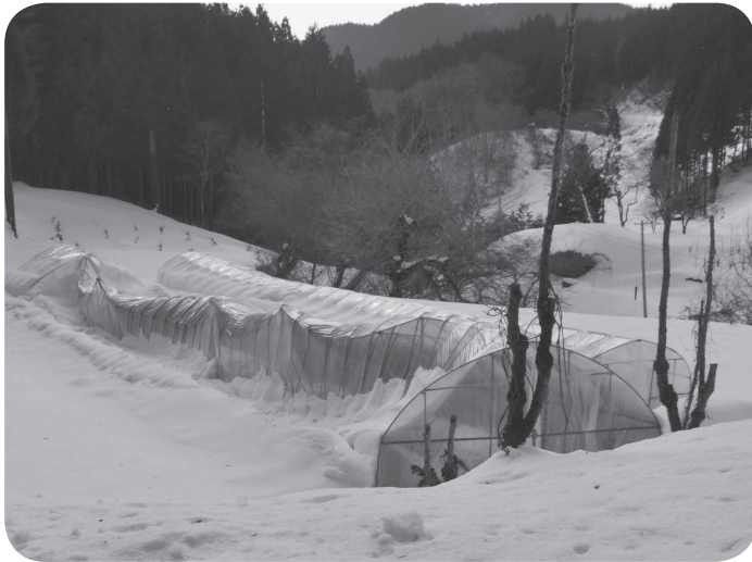
大雪により全壊したパイプハウス
