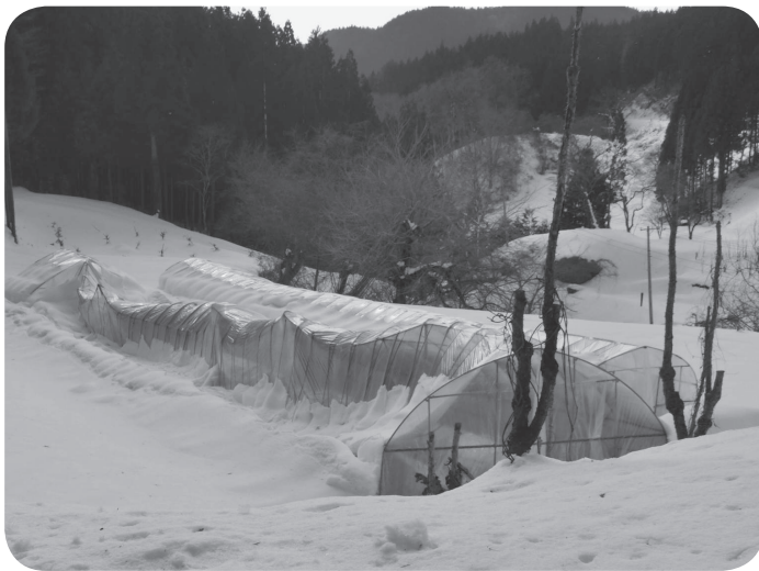
大雪により全壊したパイプハウス
