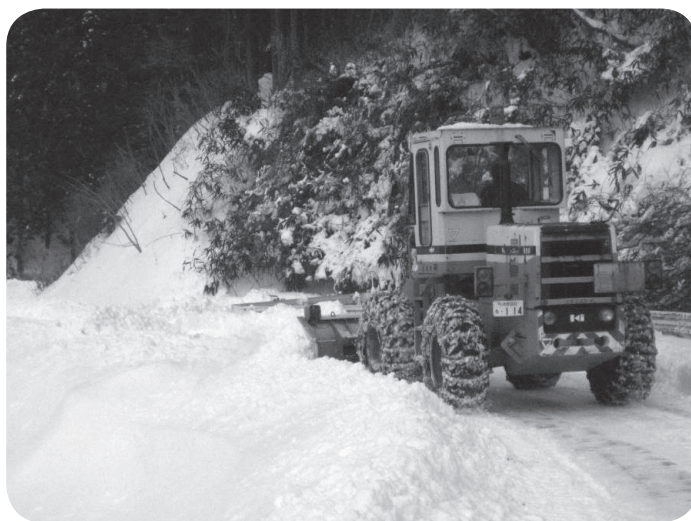
町所有のトラクターショベルでの作業
