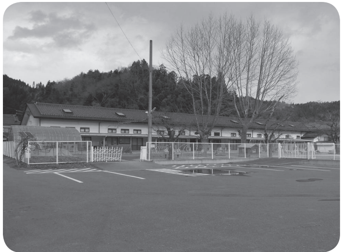
今後の活用が期待される旧古殿保育所
