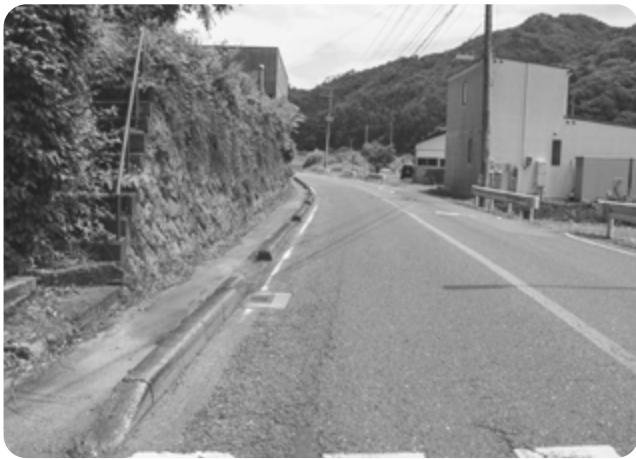
改良が望まれる 349 号線（鎌田字長光地地内）
