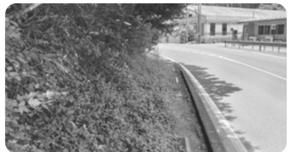
通行がままならない公共施設近くの歩道（松川字横川地内）
