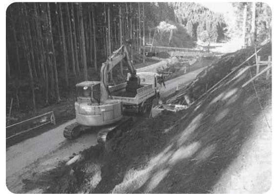
改修が行われた町道越代熊倉線
