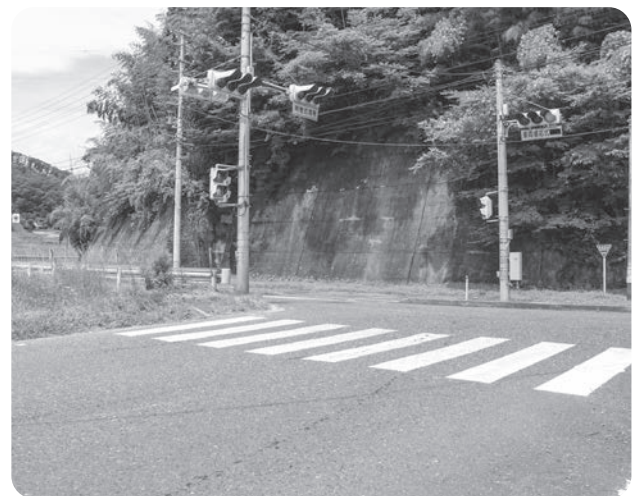
工事が進まない国道 349 号線鎌田工区
