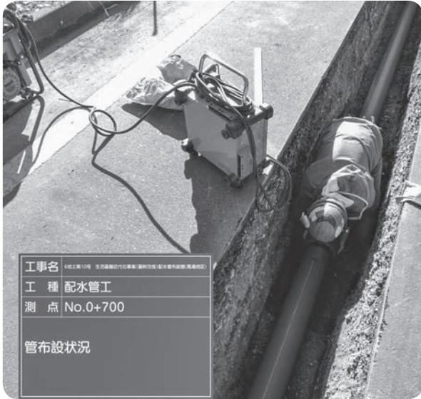
松川字馬場地内の配水管更新工事
