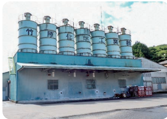
福島工場の全景
