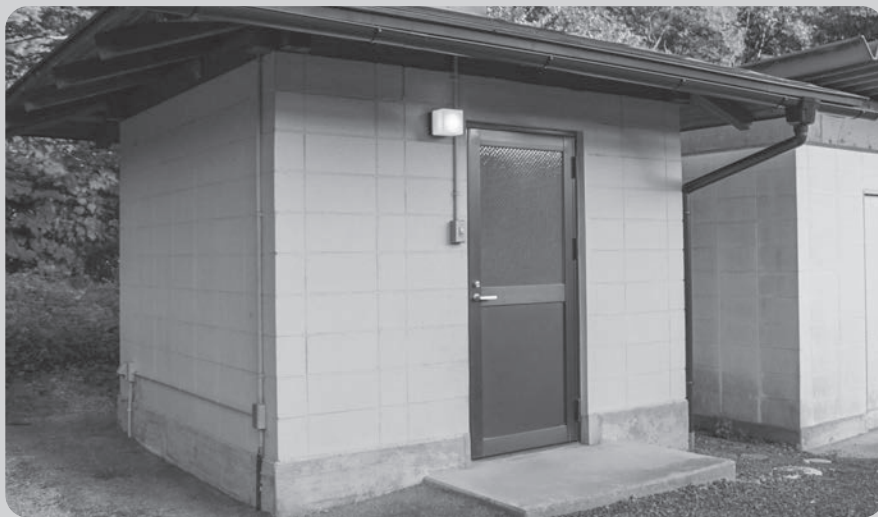
改修された屋内ゲートボール場の外トイレ
