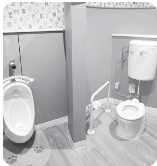
公共施設にあるキッズトイレ (矢吹町複合施設KOKOTTO)
