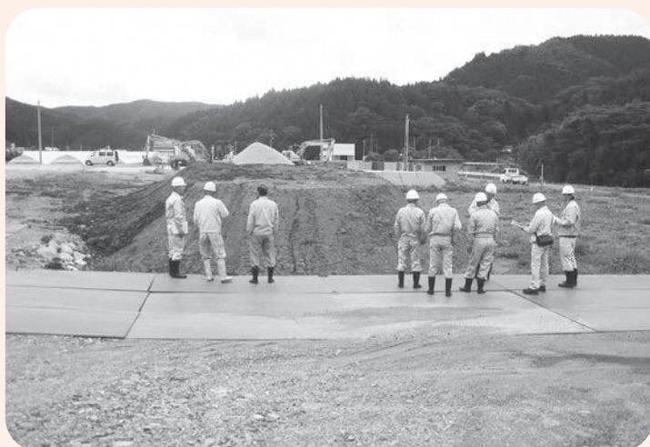
道の駅ふるどのの工事の進捗を確認する議員
