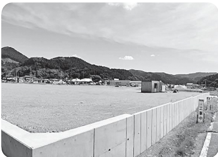
新・道の駅造成工事の現況
