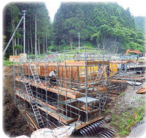
越代熊倉線地藏橋工事の施工状況
