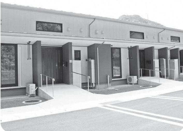
全室冷房が完備されている前木団地
