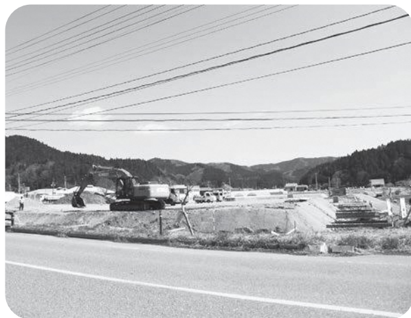
変更契約のあった道の駅拡張工事
