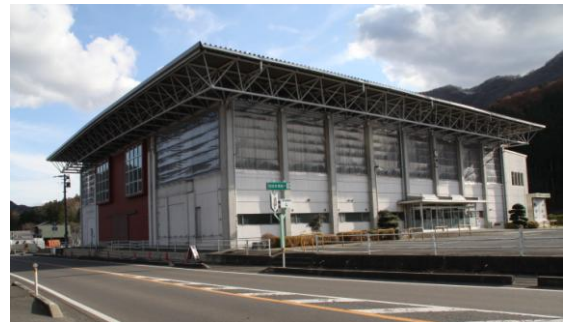
被災した町民第1体育館
