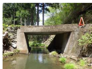
側面全景 (右側：越代熊倉線)
