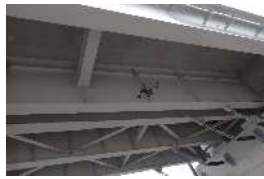
ドローンによる桁下の点検
