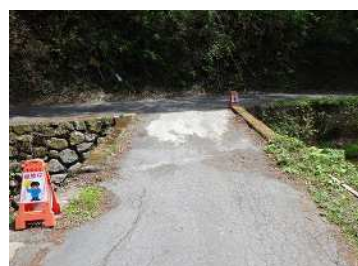
正面全景 (奥側：越代熊倉線)
