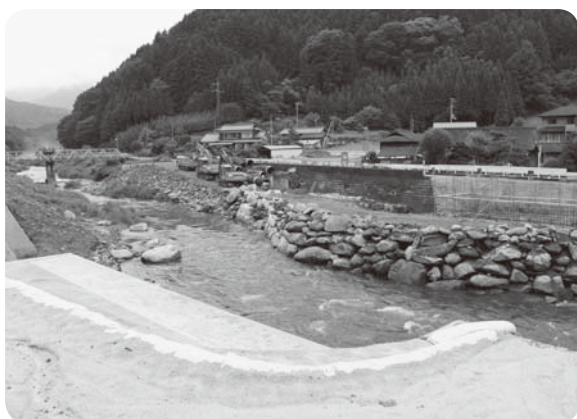
仁田橋工事(下部工)
