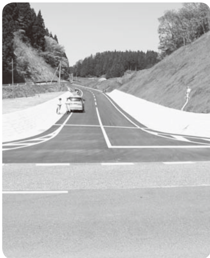
工事が完了した「町道松久保長八内線」 (長八内地内)
