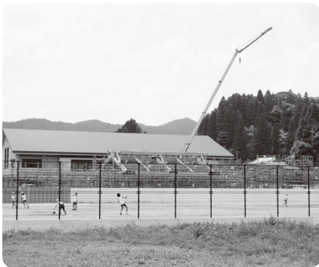
進む統合小学校増築工事
