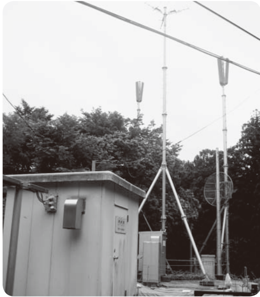
改修が進む館山中継所
