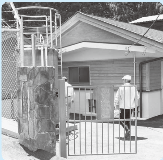
沢浄水場浄水機器設備更新工事
