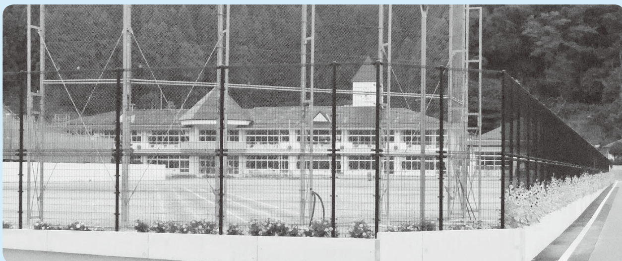
統合小学校周辺整備工事（グランド・フェンス）
