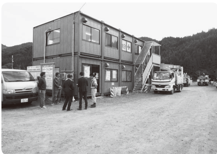
光ファイバー工事事務所前で打ち合せ
