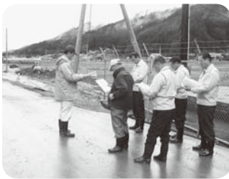
町道工事の視察
