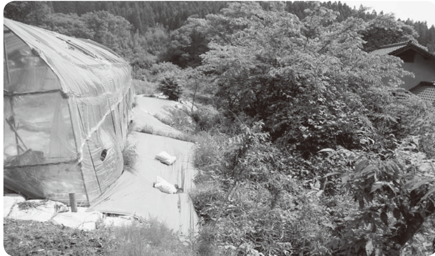
住宅付近の亀裂状況
