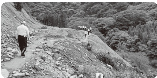
県道いわき石川線土砂崩落現場
