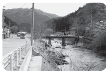
老朽化し架け替えが検討されている「馬場橋」
