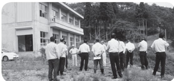
防災倉庫として利用を (旧宮本小学校)
