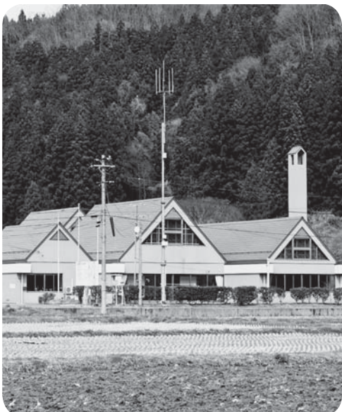
太陽光発電パネルが設置される町公民館
