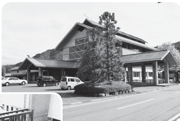
太陽光発電により拠点施設の停電対策（役場庁舎）
