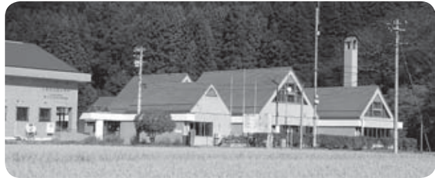
改修される町公民館
