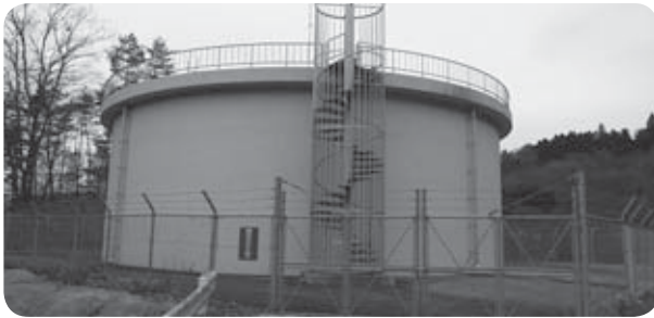
沢浄水場貯水タンク
