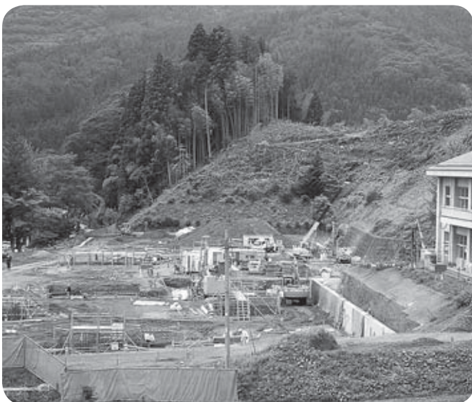
建設が進む幼保一体化施設
