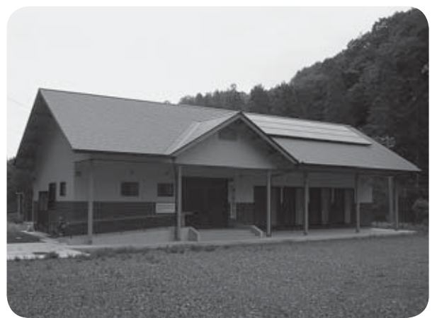
移転完成した滝平集会所
