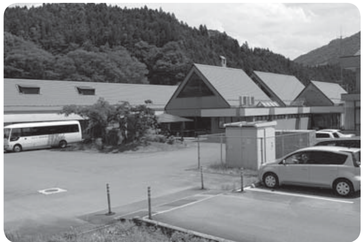
改修設計が進められている町公民館
