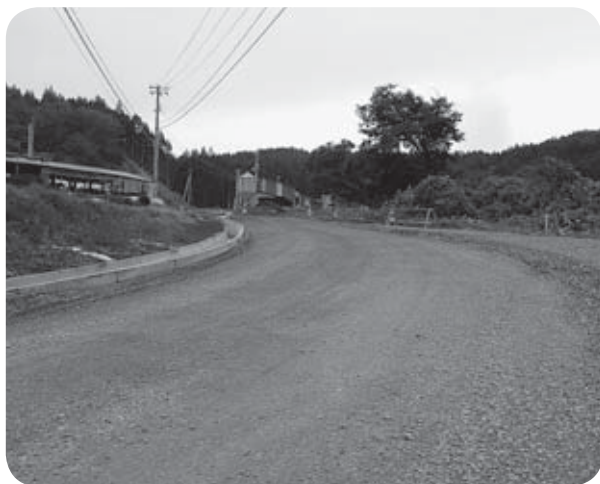
改良工事が進む竹貫田いわき線
