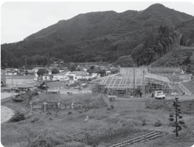
26年度開所に向け工事が進む幼保一体化施設
