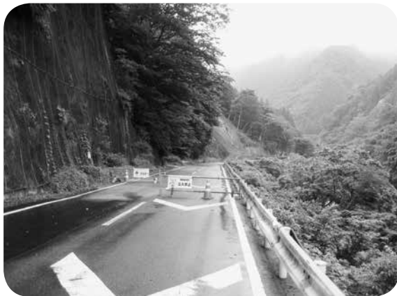
再開通に向け工事が行われている崩落現場
