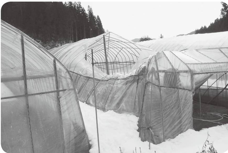
大雪により倒壊したパイプハウス
