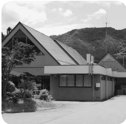
建設から31年が経過した公民館
