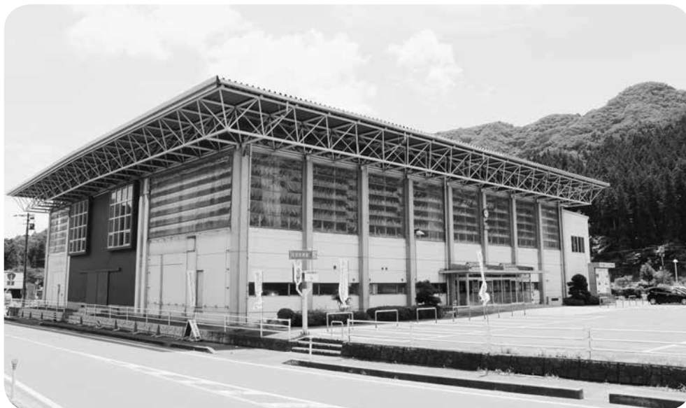
耐震改修が必要とされた体育館
