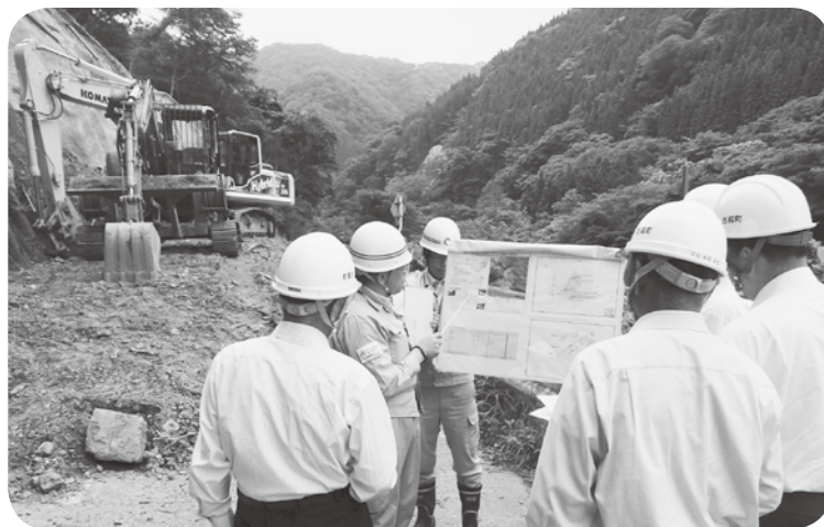
復旧工事現場を視察
