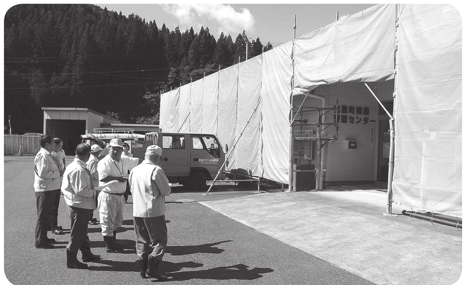
健康管理センター改修工事を視察調査
