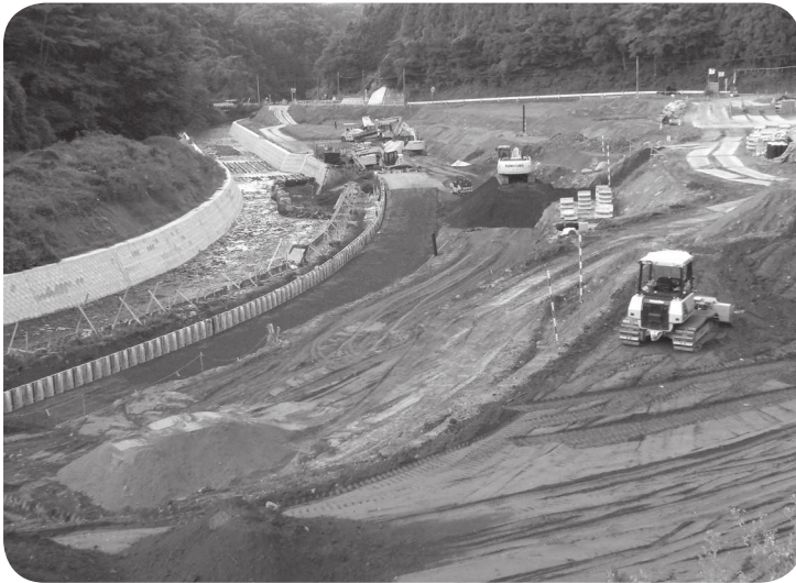
国道349号土鍋地内の工事状況
