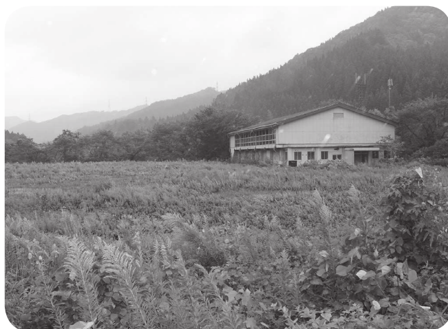
林業関連施設として計画予定の旧大原小跡
