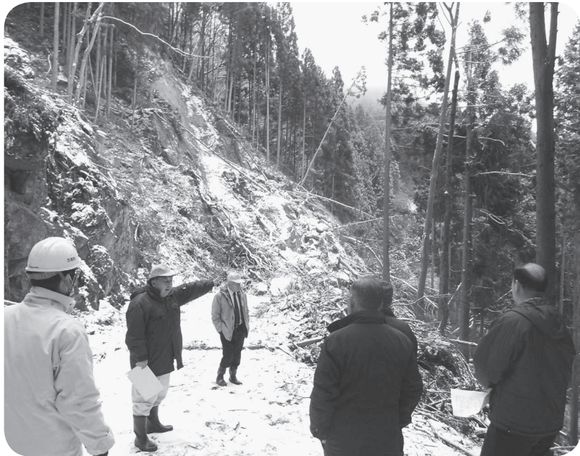
林道水沼仁田線の被害調査
