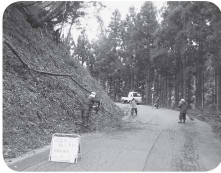
町道の支障除木と草刈清掃状況
