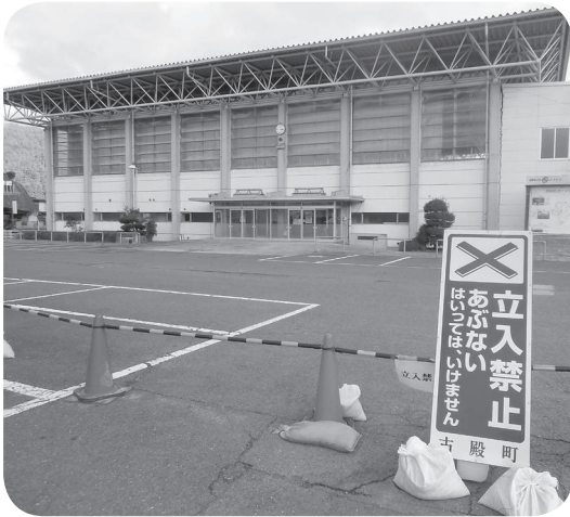
耐震診断の結果 立入禁止となった第1体育館
