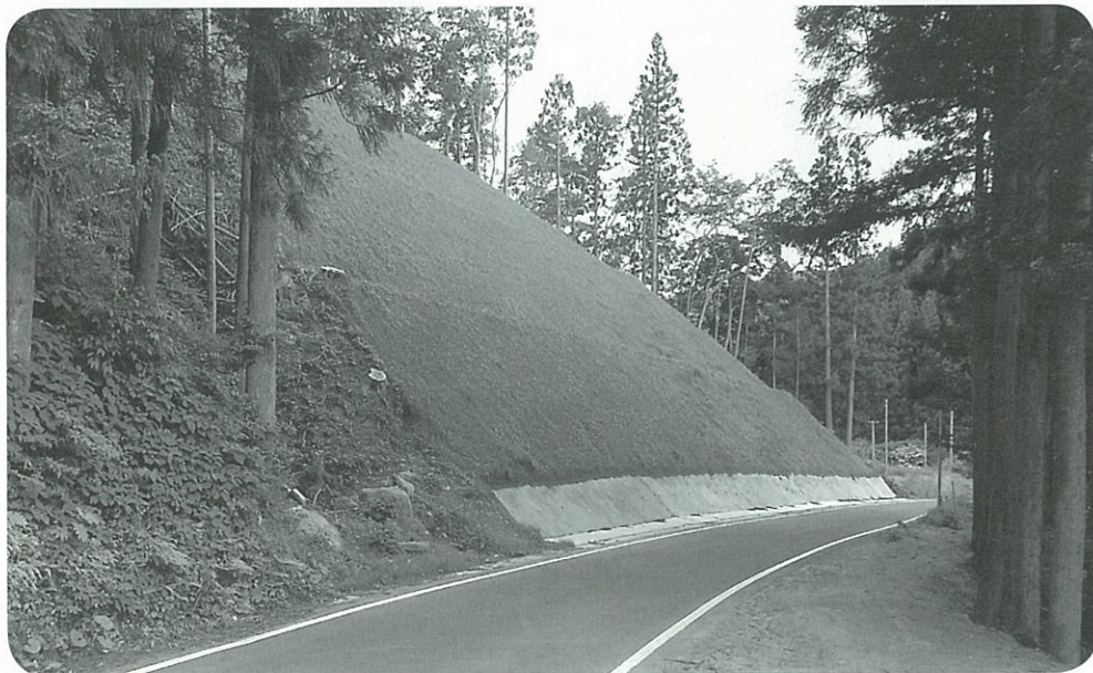
落石対策として法面整備された堀越地内
