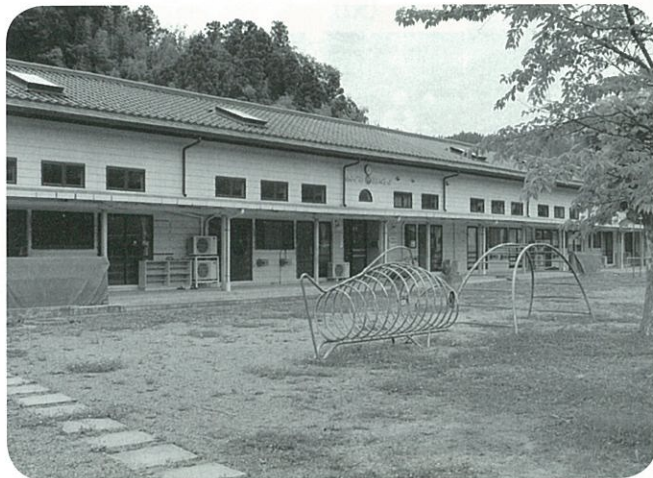
高齢者向け居住施設として検討されている保育所跡
