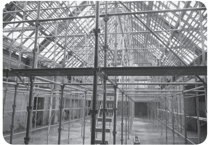
増床されるロビー部分の内部足場
