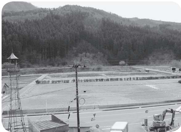
解体整地された体育館建設予定地
