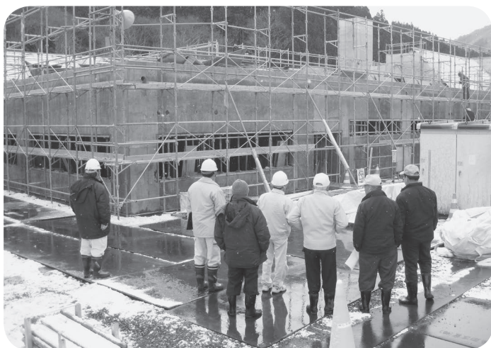
町公民館工事現場を調査
