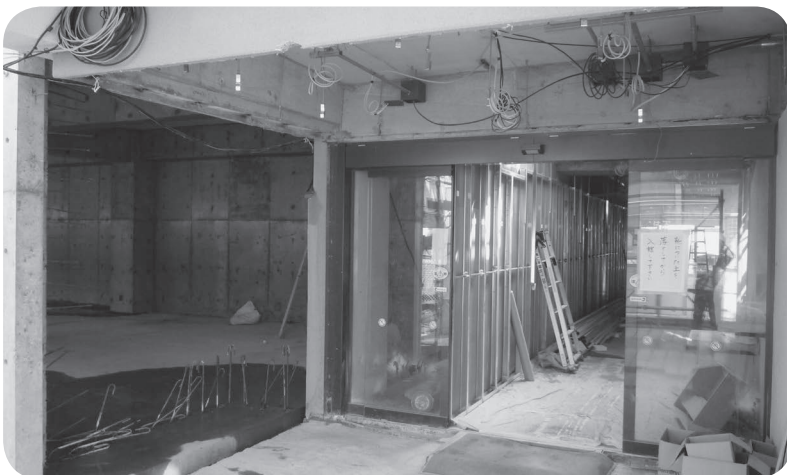
工事中の西側玄関付近
