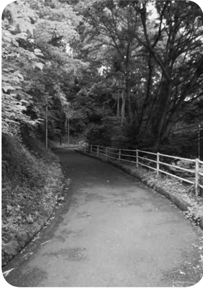
安全確保が望まれる通学路
