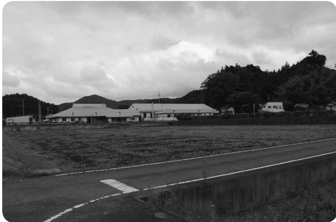
町民第1体育館建設予定地
