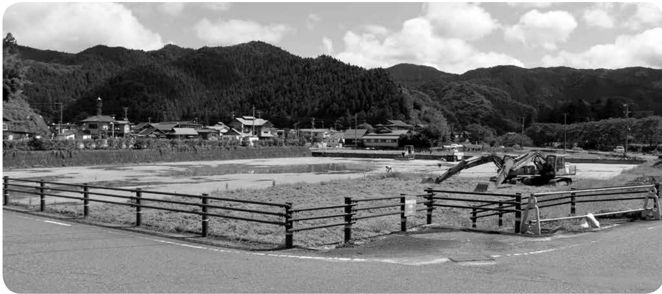
用地造成工事が進む町民第1体育館建設用地
