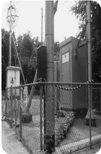
老朽化が進む中継基地
