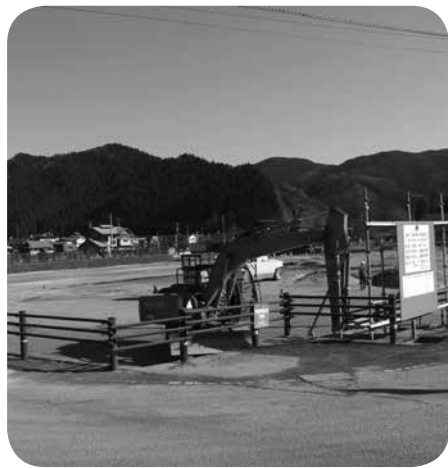
町民第1体育館建設工事
