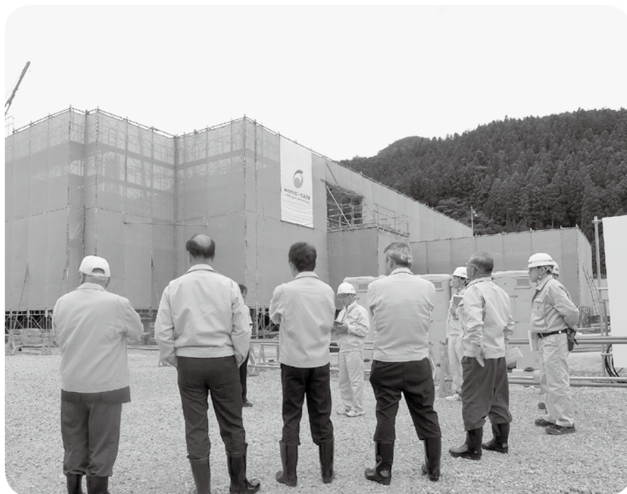
工事が進む町民第1体育館
