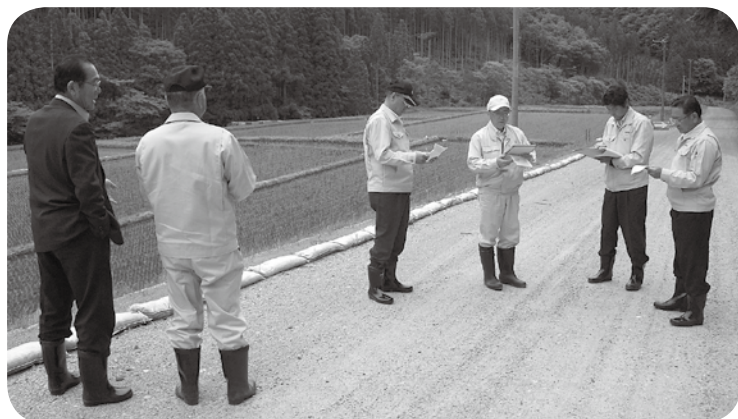
町道越代熊倉線の進捗状況を確認
