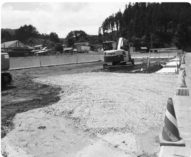
宅地造成箇所
