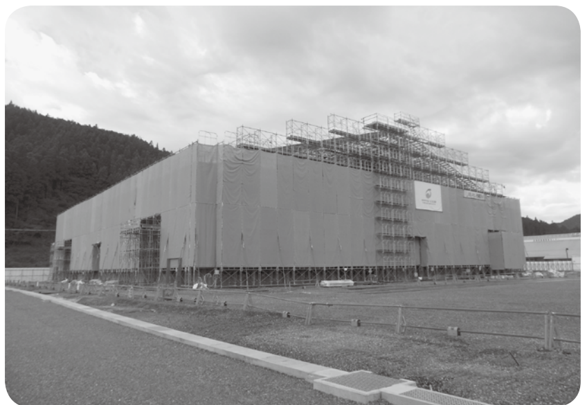
建設中の町民第1体育館
