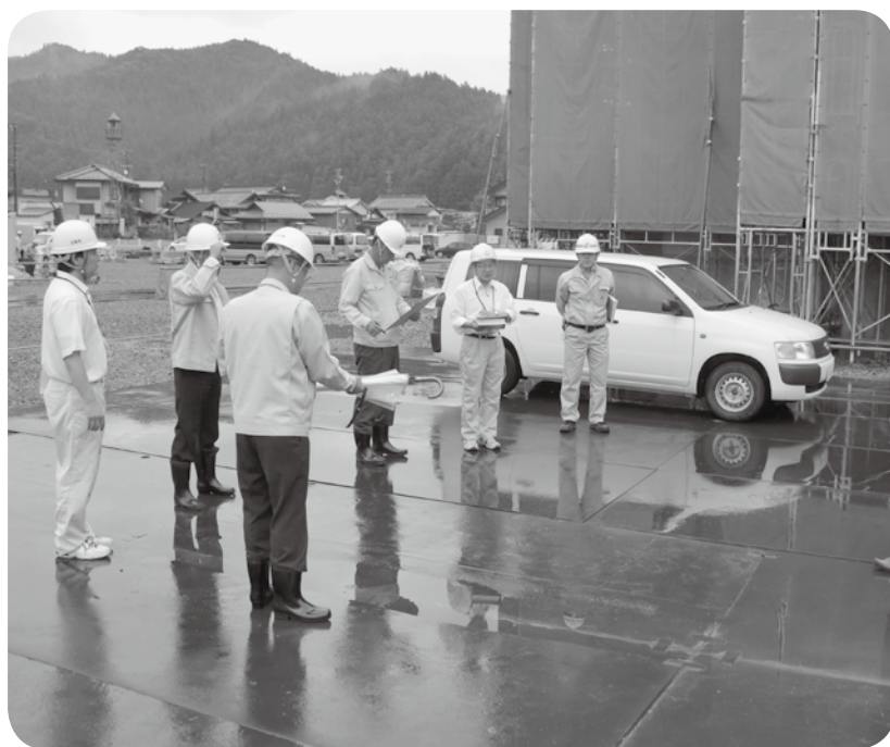
町民第1体育館の進捗状況を確認
