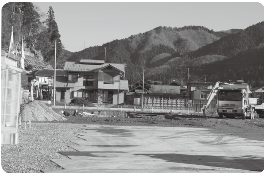
基礎工事が始まった古殿分署
