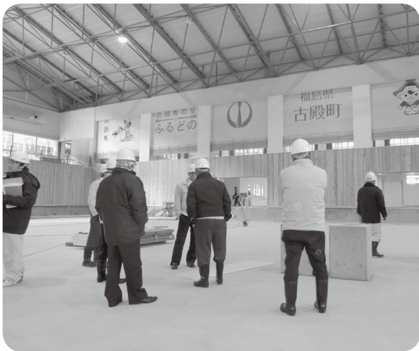
工事が進む町民第1体育館の内観
