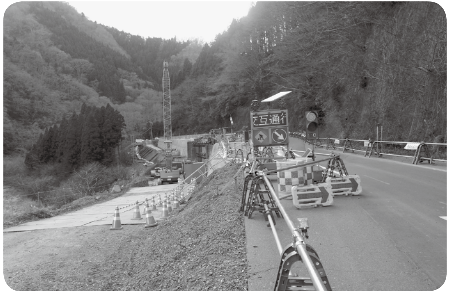
改良が進む県道いわき石川線（いわき地内御齊所街道）
