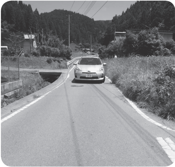
道路改良が望まれる一級町道竹貫古殿線
