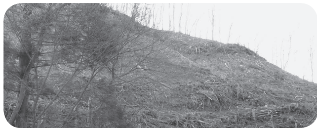
土砂崩れを起こし、残材流出が心配される杉の伐採現場（田口松森地内）
