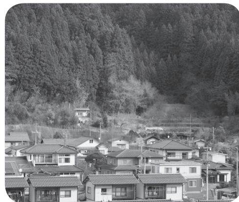
住宅建設が進む町内
