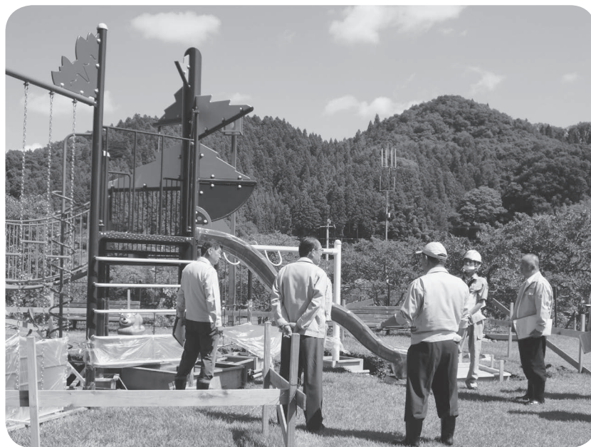
遊具の設置状況を確認
