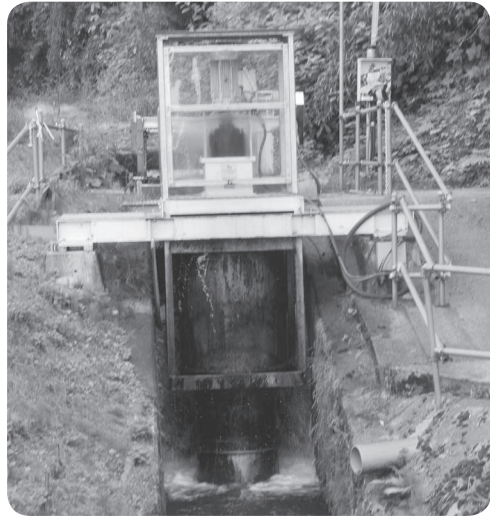
吊り下げ式で稼働中の小水力発電機 (株)北陸精機社内(富山県)
