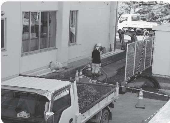
小学校の空調設備にともなう電力の改修工事
