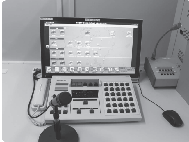
防災行政無線デジタル化改修工事
