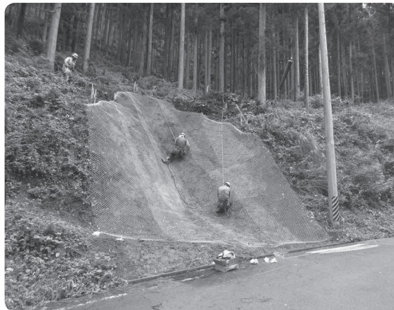
台風19号災害復旧工事
