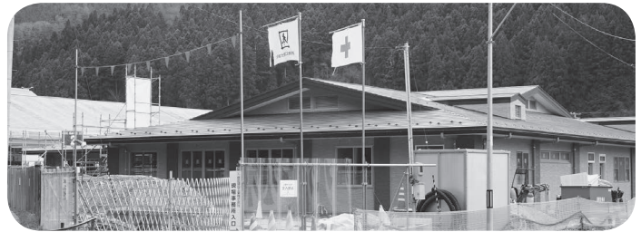
変更契約後、順調に工事が進むコスモス荘
