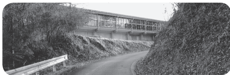
町民グラウンドに接続する見通しの悪い道路
