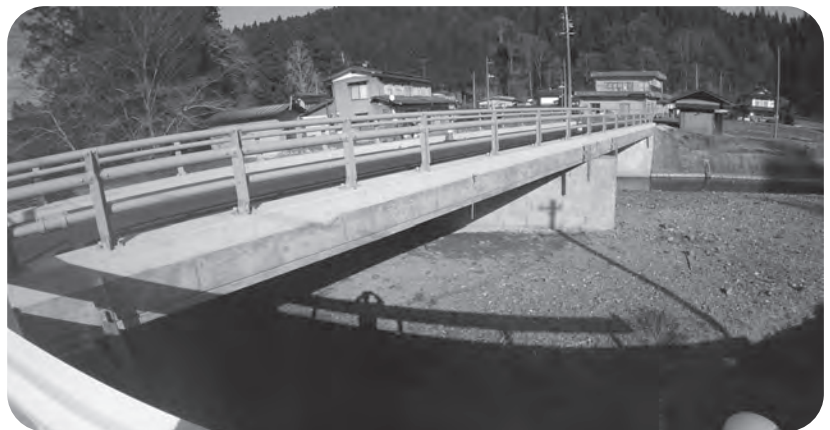
長寿命化修繕工事が完了した橋梁 (下山上地内の古殿橋)
