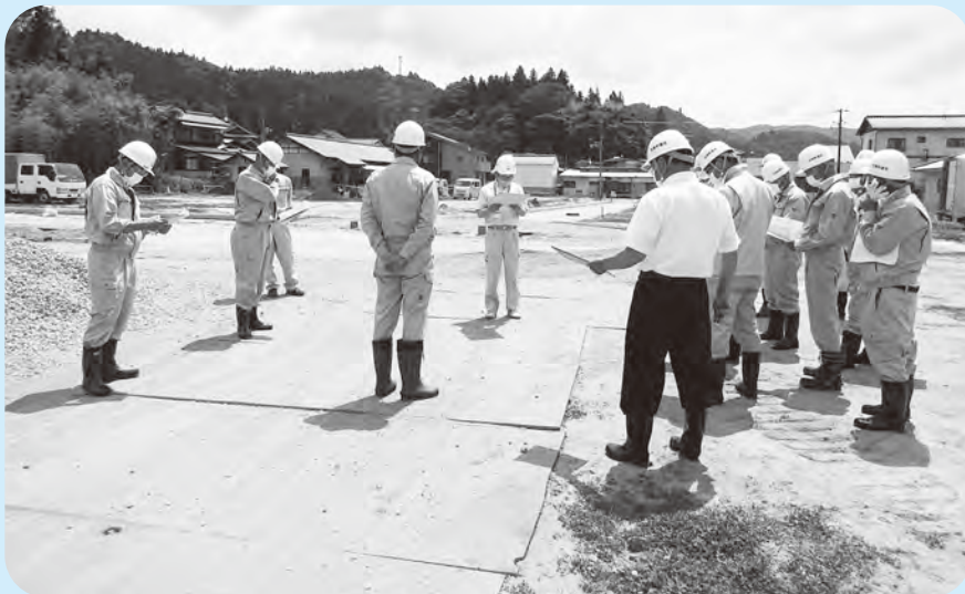
区画整備が進められる宅地造成工事
