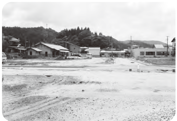
造成工事が進められている竹貫地区分譲地
