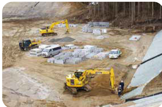
工事現場の様子
